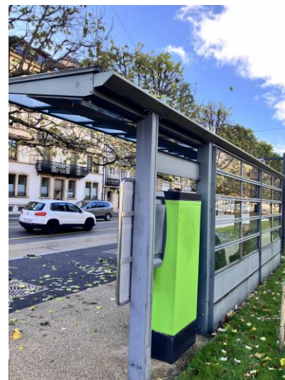
Abribus en milieu urbain (Neuchâtel)
