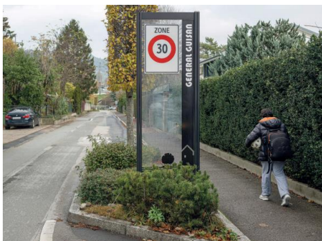
Totem conservant la visibilité dans un décrochement horizontal végétalisé et arboré (Rolle)
