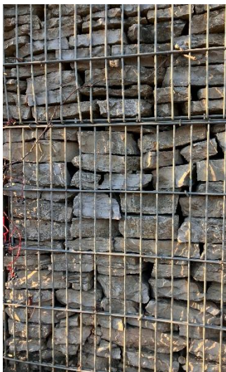
Mur de soutènement en gabions (Neuchâtel)
