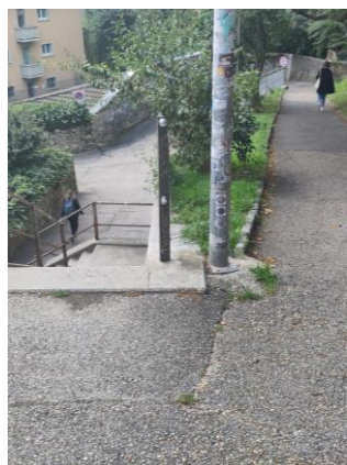
Rampe à proximité immédiate d'un escalier (Neuchâtel)
