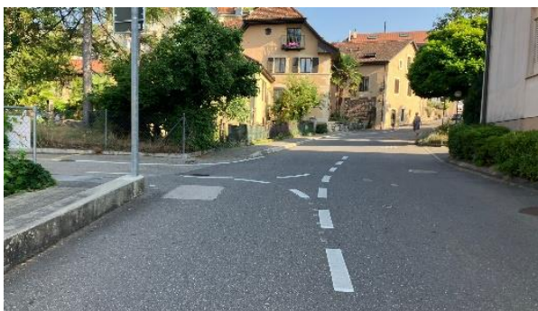
Mise en avant de la priorité de droite (Saint-Aubin)
