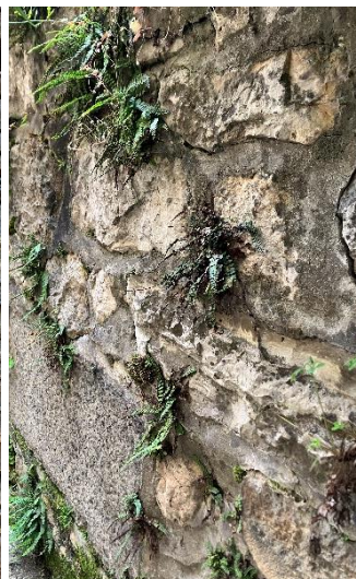
Mur de soutènement en pierres jointoyées (Neuchâtel)
