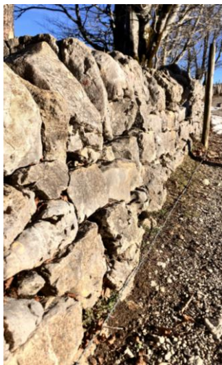
Mur à deux pans en pierres sèches (Val-de-Travers)
