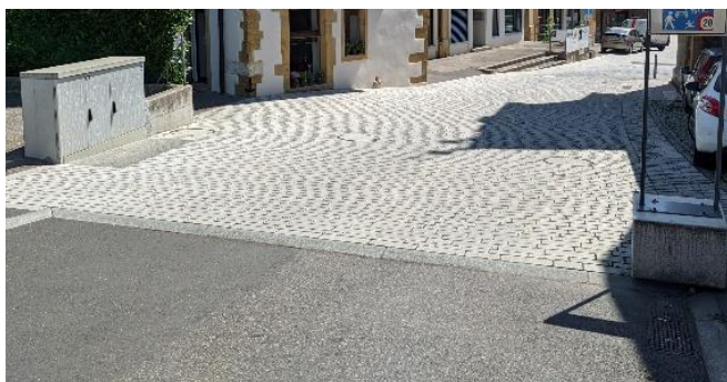
Rehaussement général de la chaussée et revêtement soulignant le changement de zone (Saint-Blaise)
