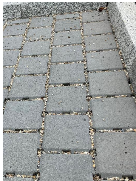
Places de stationnement (Neuchâtel ; modèle : pavés écologiques VS5 de CREABETON)
