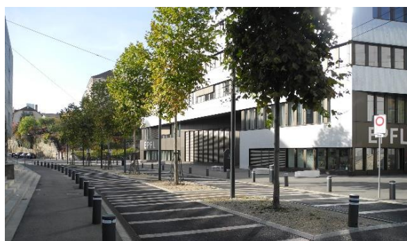
Bande centrale polyvalente arborée sur un axe à orientation trafic (Neuchâtel)
