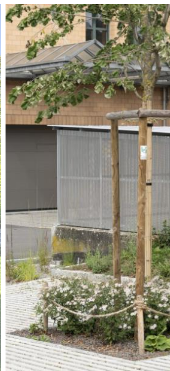
Fosse de plantation intégrant la gestion des eaux (Köniz)
