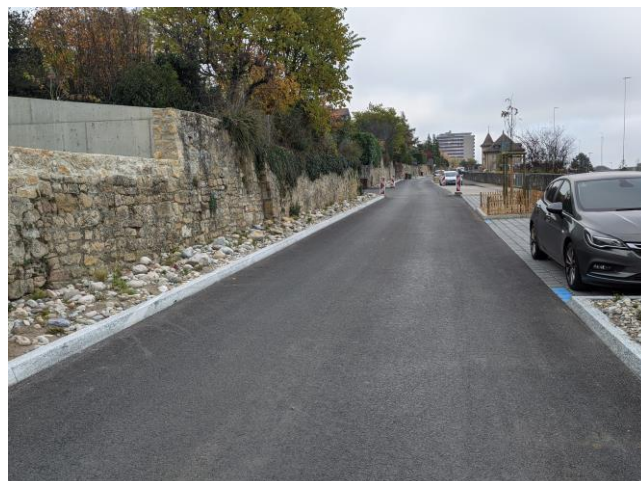
Rue du Clos-de-Serrières, Neuchâtel
