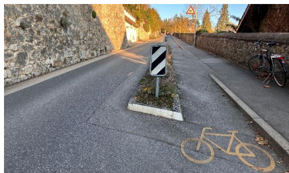
Décrochement horizontal végétalisé avec bypass vélo (Neuchâtel)
