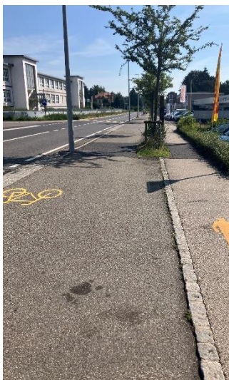
Piste cyclable bi-directionnelle entre le trottoir et la chaussée (Neuchâtel)
