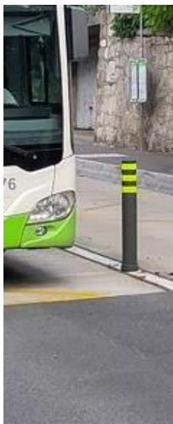
Potelet sur la chaussée (Neuchâtel)
