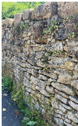
Mur de soutènement en pierres sèches (Hauterive)
