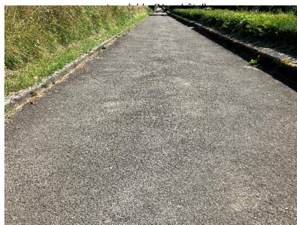
Bitume poreux sur cheminement piéton (Neuchâtel)
