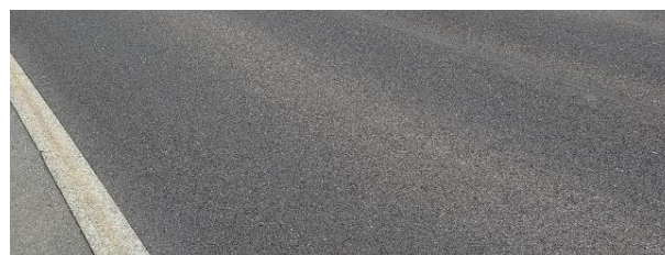
Bitume sur la chaussée d'une zone 30 (Neuchâtel)
