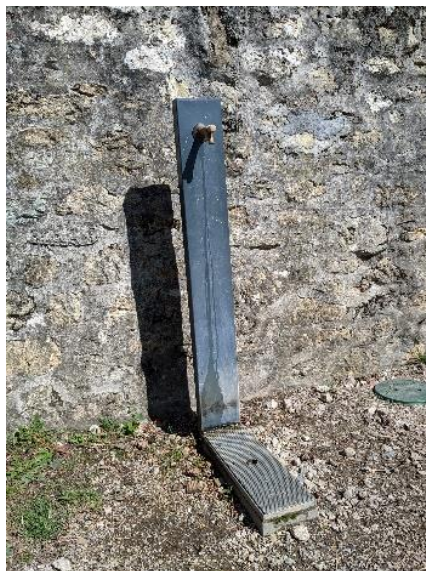
Point d'eau (Neuchâtel)
