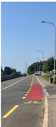
Mise en évidence d'un point de conflit sur une bande cyclable discontinue (Bevaix)
